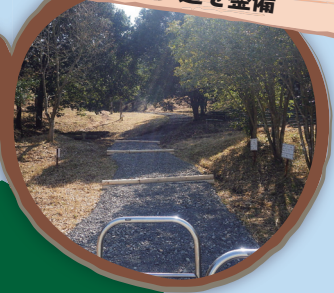
尾道ふれあいの里の 遊歩道を整備
