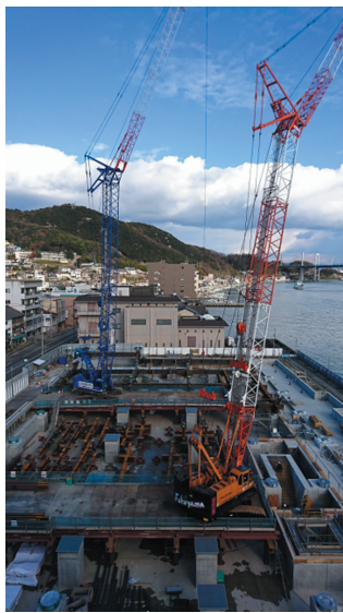
本庁舎屋上から見た 建設現場の様子 (平成30年12月時点)
